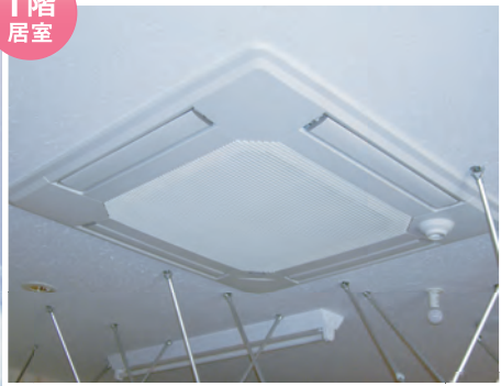
▲1階居室に設置された 4方向天井カセット形〈人感ムーブアイ360〉
