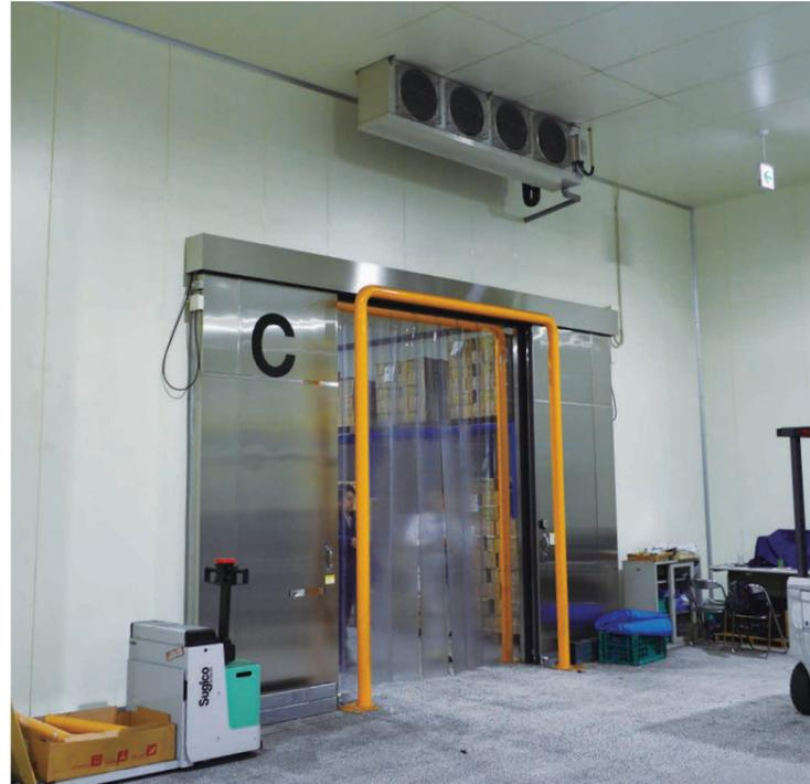
▲前室のユニットクーラは低騒音/低風量仕様。低温作業場として使うので5.5℃に設定
