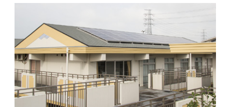
▲太陽光発電システムの導入により、環境に配慮した福祉施設づくりをさらに推進
