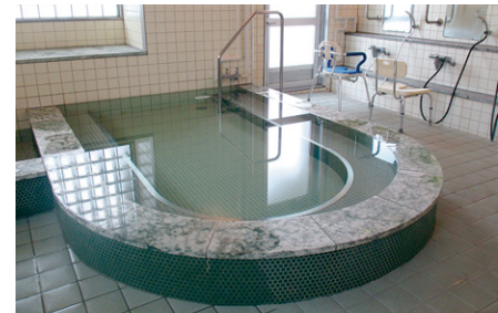
▲負荷側の浴室(一例)
