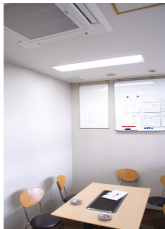
▲使用場所に応じた機種選定を実施。喫煙室には天井カセット形(4方向吹出)を採用
