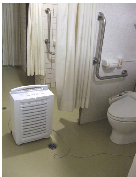
▲トイレで発生したニオイは廊下に漏れやすかったのですが、脱臭機を使うことでニオイが広がる前に脱臭できるようになりました。
