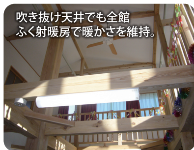
2階も各所にパネルヒーターを設置
