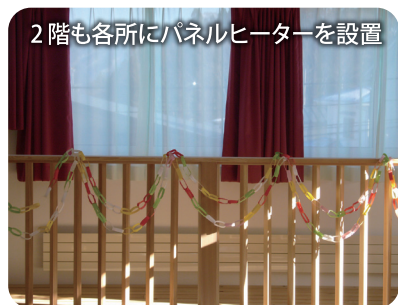
吹き抜け天井でも全館 ふく射暖房で暖かさを維持。
