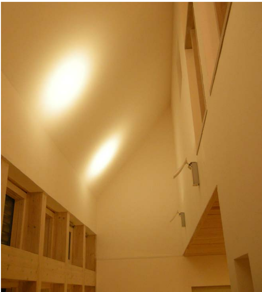
吹き抜け空間
