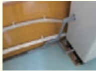
◀ドレン水は配管を通して、室外へ排水
