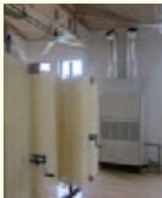
▲5馬力タイプ。うどん乾燥室(約100m 2 )に1台設置
