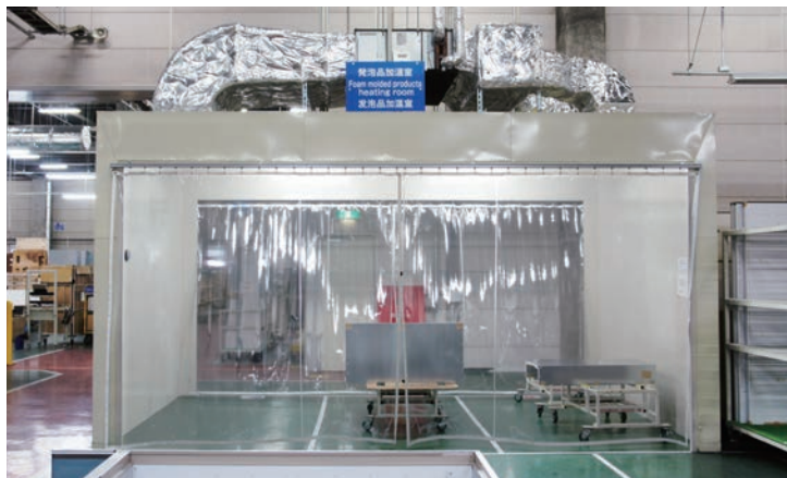
▲ウレタン封入を行う加温乾燥室
