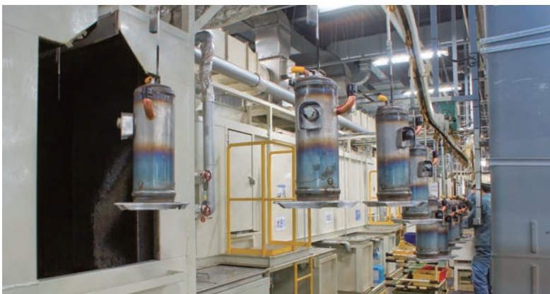
▲塗装前の湯洗工程(温水利用側)
