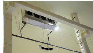
▲ユニットクーラとエア搬送ファンの設置場所は気流を考慮して決定
