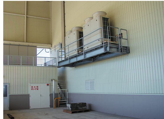
▲災害対策で高所設置されたコンデンシングユニット(中央)とキュービクル(左)
