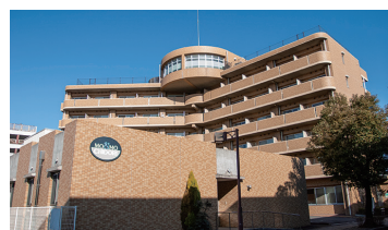
▲「ケアハウスちどり」様はSC造7階建、延床面積約3,088㎡、施設定員50名。手前低層の建物は系列の特別養護老人ホーム
