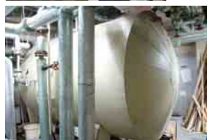
▲既存の貯湯槽と灯油焚き真空式温水ヒーター
