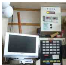
◀遠方操作盤を事務室に置き、手元で管理
