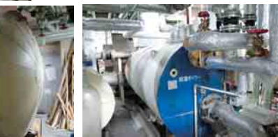
▲既存の貯湯槽と灯油焚き真空式温水ヒーター
