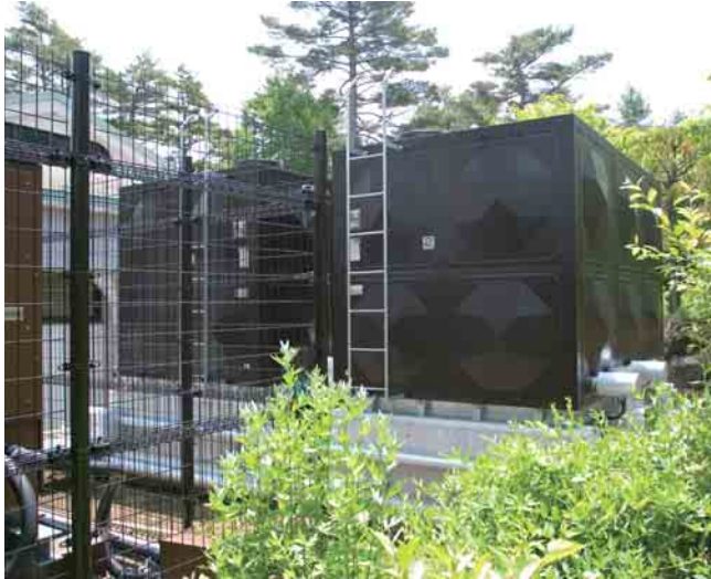
▲貯湯槽は12t×2基。通常はステンレスやアルミのパネル色だが、国立公園のため景観への配慮から特注で濃茶色に塗装
