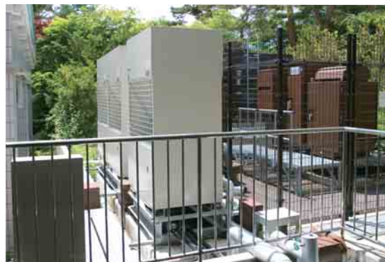
▲業務用エコキュート サニーバックQ ECOを3台導入
