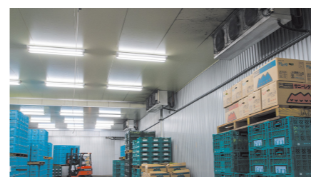
▲天吊形ユニットクーラUCL-N10VHB×4(2系統)で冷却する予冷庫。庫内温度は5℃
