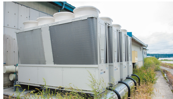
▲一体空冷式インバータブラインクーラBALV-EN50A形。50馬力筐体4台を連結設置。各ユニットは自立して出口温度制御を行う機能を持っており、代表機が故障した場合も運転を継続できる。また、1モジュールに圧縮機を4台搭載し、2系統のブライン回路をもつので危険分散にも対応
