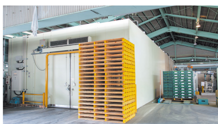
▲予冷庫。大きさはW29,200×D8,100×H4,000mm。エアーカーテンも三菱電機製
