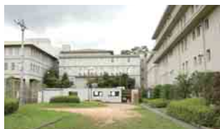
▲敷地の東側に研修棟2棟と宿泊棟2棟が連なる。業務用エコキュートで給湯を賄うのは、S研修棟(左端)とN宿泊棟(正面&右手奥側)
