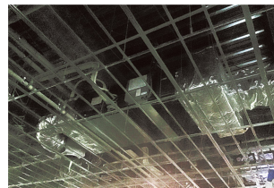
▲外調機(外気処理ユニット)の 施工状況
