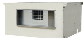
▲ハイブリッド式産業用除湿機を3台、天井裏に設置
