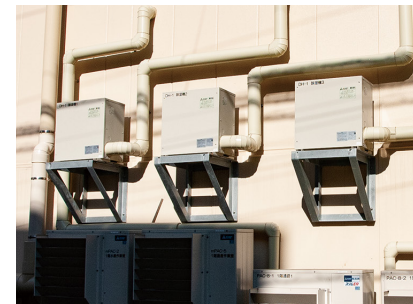
▲ハイブリッド式除湿機の圧縮機ユニット (天井裏設置も可能)
