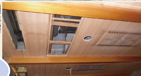
▲室内側の更新工事の様子。チラー&ファンコイルユニットから個別空調への入替えて個別発停による柔軟性が格段に向上。
