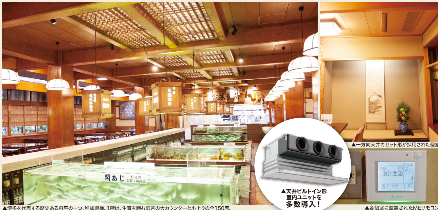
▲博多を代表する歴史ある料亭の一つ、稚加榮様。1階は、生簀を囲む銀杏の大カウンターと小上りの全150席。空調機は天井ビルトイン形(グランマルチ)を新設
