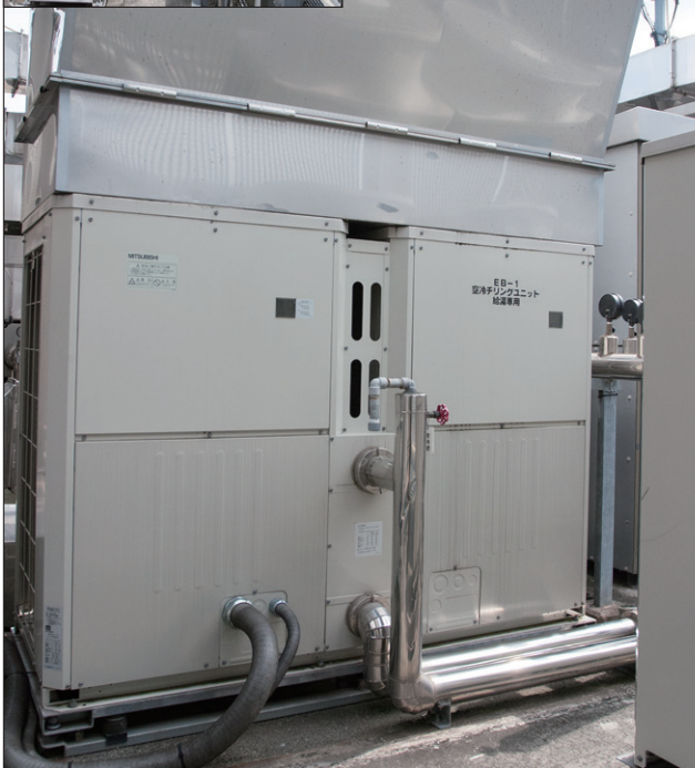
▲ホットウォーターヒートポンプ20馬力機(CAHV-P500AK-H)
