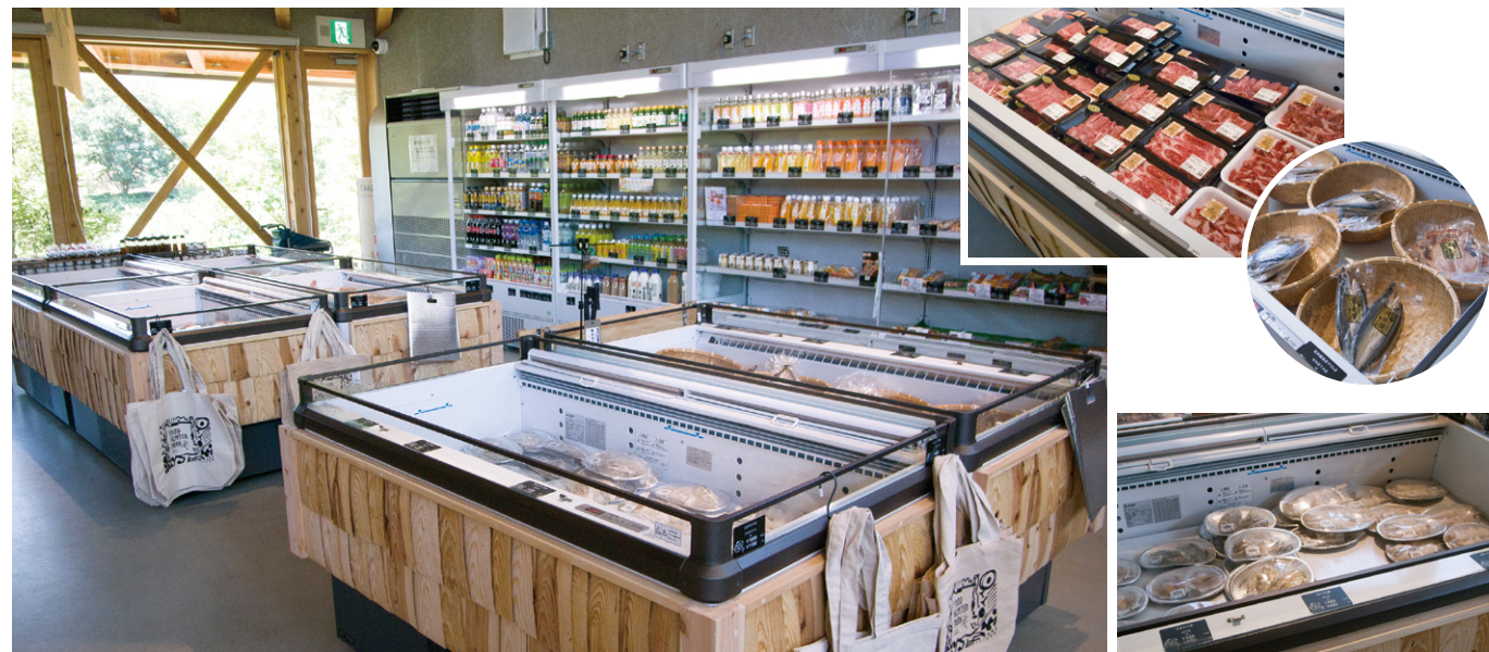
▲肉や魚、干物等は、平行両面5尺ケース4台と2台の2アイランドで陳列。冷凍/冷蔵の2温度帯切替可能なショーケースの特長を活かし、チルド以外に冷凍素材も販売。ケース周囲の木枠はオリジナル設計
