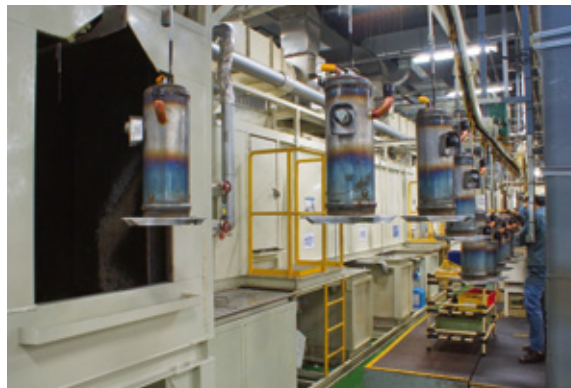
塗装前の湯洗工程(温水利用側)
