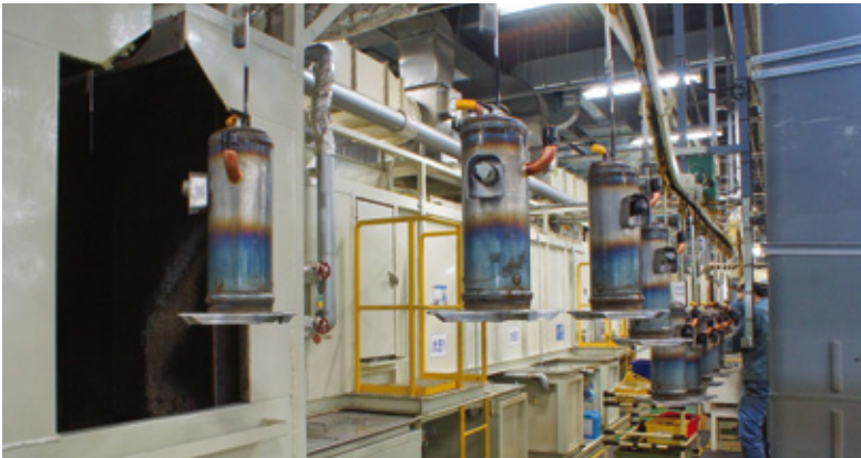
▲塗装前の湯洗工程(温水利用側)
