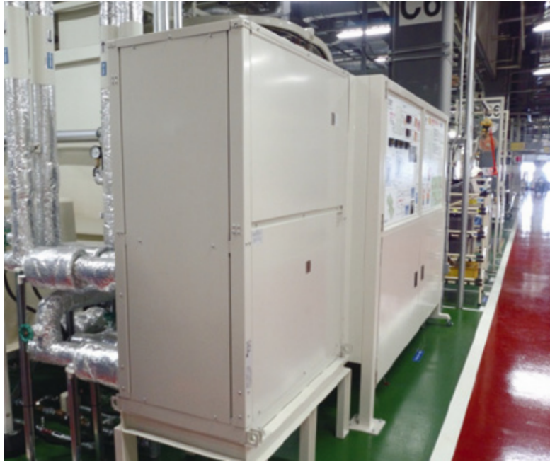
▲排熱回収型 水熱源ヒートポンプ CRHV-P650A
