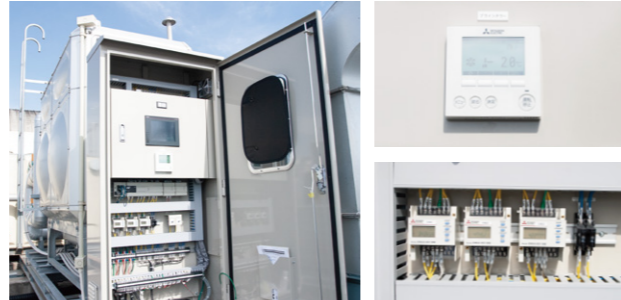
▲ブラインクーラのリモコンを組み込んだ制御盤。三菱電機製GOTやエネルギー計測ユニットを活用した計装システムは株式会社ミックプラント様のオリジナル設計
