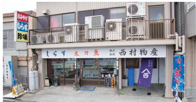
▲設備用パッケージエアコンは作業中 ▲奥の3台が選別室用の設備用パッケージエアコンの稼働。設定湿度は20℃ ▲奥の3台が選別室用の設備用パッケージエアコン室外機(耐重塩害仕様)、手前は冷蔵庫用
