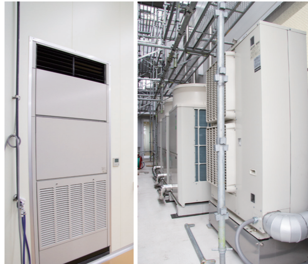
▲設備用パッケージエアコンは作業中 ▲奥の3台が選別室用の設備用パッケージエアコンの稼働。設定湿度は20℃ ▲奥の3台が選別室用の設備用パッケージエアコン室外機(耐重塩害仕様)、手前は冷蔵庫用
