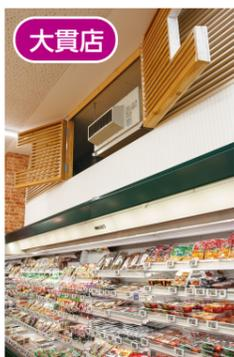
▲除湿機は和日記・漬物用多段ショーケースの上部壁面に収納する形で設置。画像は吸込ルーバー開放時
