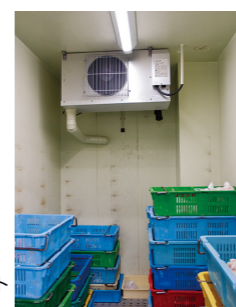
▶一階の冷蔵庫(0℃)はユニットクーラ3馬力×3台で冷却
