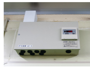
▲冷凍庫・冷蔵庫の扉上に設置された制御ボックスとコントローラ
