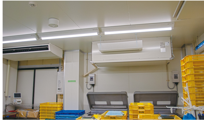
▲二階も2馬力の天吊形除湿機を空調機の横に設置
