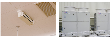
▲三菱電機のエアー搬送ファンを結露対策のため導入。天井裏にも設置している ▲惣菜・和日配系統のユニット、ECOV-D225MA
