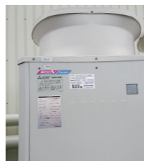
▲三菱電機のエアー搬送ファンを結露対策のため導入。天井裏にも設置している ▲惣菜・和日配系統のユニット、ECOV-D225MA
