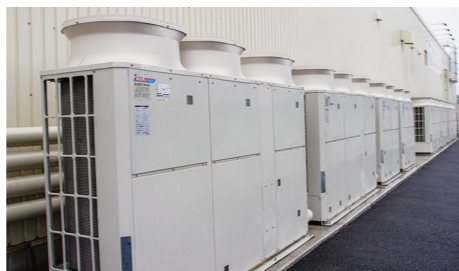
▲コンデンシングユニットは店舗の外壁沿いに集中設置
