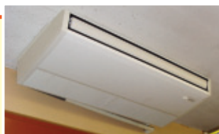
MPCZ-ERP140KMx2 天吊形 ムーブアイ標準装備
