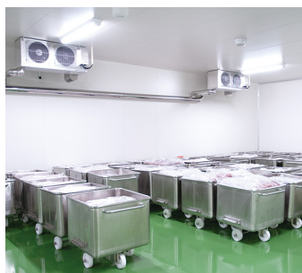
▲塩漬庫のクールマルチ(R463A-J)。基本的 に生産エリアの機器はカチオン防触仕様
