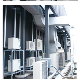
▲コンデンシングユニットは、 熟成庫用などセット品を除 き、冷媒R463A-Jを封入
