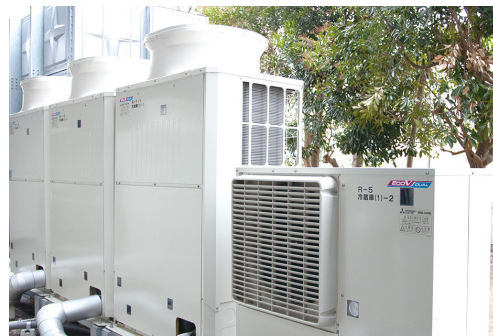
▲コンデンシングユニットは、 熟成庫用などセット品を除 き、冷媒R463A-Jを封入
