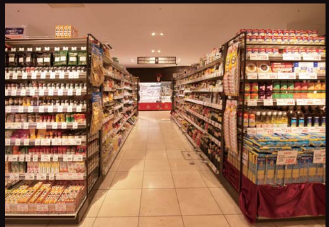
gondola 什器には、ユニバーサルダウンライトに光を横へ長く広げるスプレッドレンズを装着し照射。最小限の器具台数で商品を明るく照らす工夫です。
