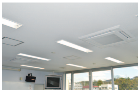
▲応接室や教室などの正方形の空間には 4方向カセットをご採用
