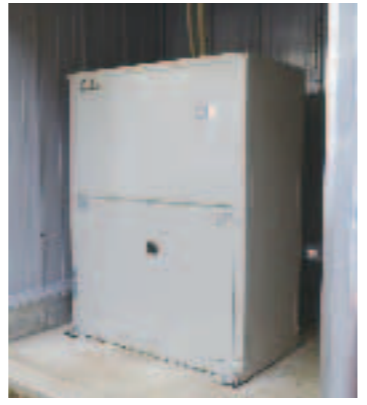
▲水熱源ヒートポンプで保温された貸切風呂。 ▲34℃の温泉水を水熱源ヒートポンプの熱源水として利用。 ▲今回ご採用いただいた水熱源ヒートポンプ
