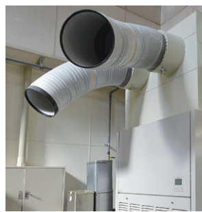
▲作業エリアのスポット空調と飴成型時の冷却工程に使用
