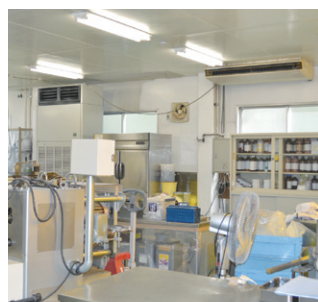
▲作業エリアのスポット空調と飴成型時の冷却工程に使用
