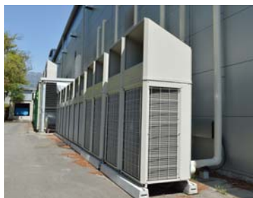
▲室外ユニット 寒冷地では欠かせない防雪フードを完備した室外ユニット
