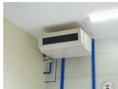
▲床面に設置スペースが無い場所には工場用天吊形を採用
