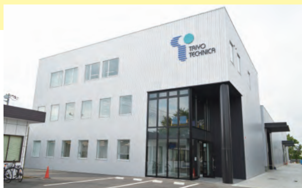
納入機種 PFHV-P224DMJ1 床置形 8馬力 4セット(HEPAフィルター組込)
