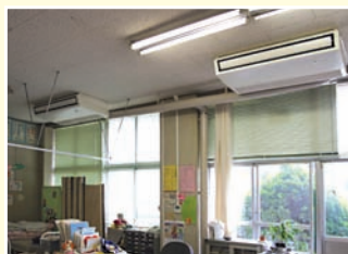
▲保健室に設置された天吊形 同時ツイン MPCZX-ERP160KM 1セット
