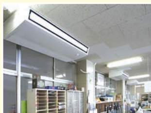
▲職員室に並んだ天吊形 MPCZ-ERP80KM 2セット MPCZ-ERP112KM 2セット
