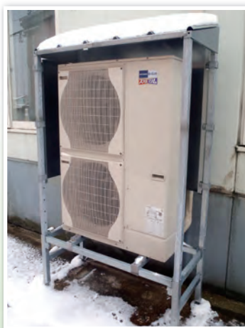
▲専用架台に設置された室外ユニット▲
