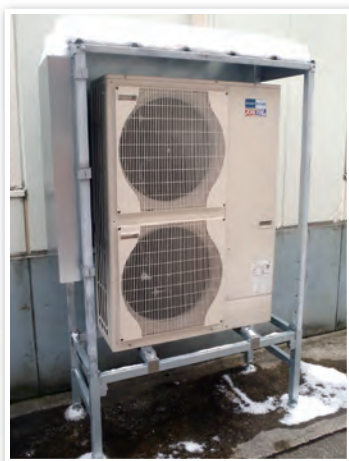
▲専用架台に設置された室外ユニット▲
