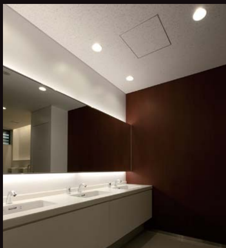
トイレ ミラー裏面に設置したLED間接照明器具によって、明るく開放的な空間を作っています。
