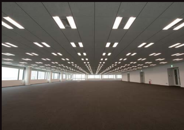
基準階事務室 色温度4000KのLEDグリッド天井器具を採用。適正照度補正、昼光利用制御などによって、大幅な省エネを図っています。
