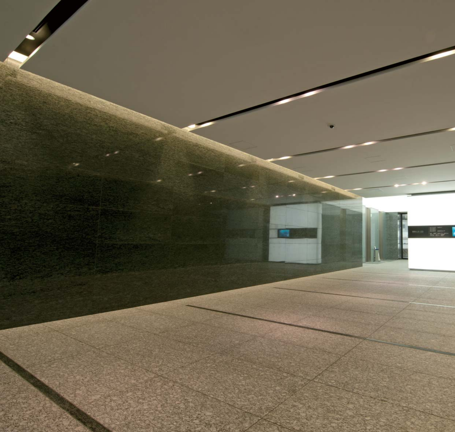
エントランスホール スリット内にLED集光形ダウンライトを設置し、器具の存在感を無くしたシンプルな空間を作っています。
