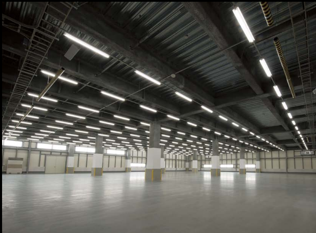
直管形LEDランプ搭載 直付形ベースライト LDL40×1 (FLR40W×1相当)
