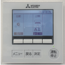
▲PAR-46MA FF式暖房機との併用ですが、設定温度20℃で十分あたたかいです。部屋の4面のうち2面に窓がある点、出入口付近に外気が流入しやすい点から、「ムラ無し」モードに設定しています。
