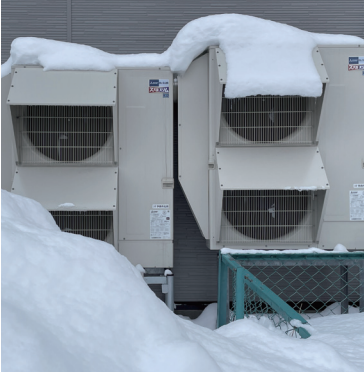
◀PUZ-DHRMP112KA3 防雪フードと架台設置で積雪対策をしています。雪による室外機能力の低下や故障を防ぐ事を目的に、寒冷地では防雪フードの設置が推奨されています。
