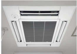
▲PAR-46MA FF式暖房機との併用ですが、設定温度20℃で十分あたたかいです。部屋の4面のうち2面に窓がある点、出入口付近に外気が流入しやすい点から、「ムラ無し」モードに設定しています。
