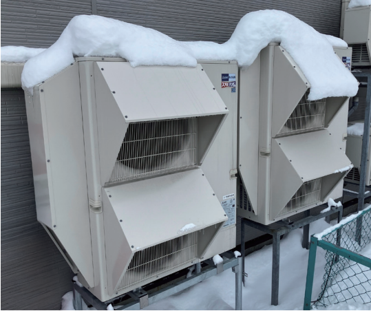
◀PUZ-DHRMP112KA3 防雪フードと架台設置で積雪対策をしています。雪による室外機能力の低下や故障を防ぐ事を目的に、寒冷地では防雪フードの設置が推奨されています。
