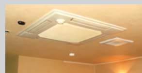
▲室内ユニット(4方向天井カセット形)
