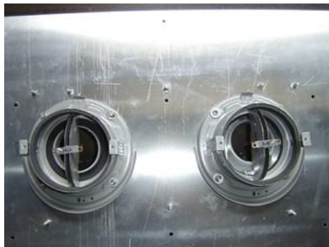
フード取付板取付状態図(給排)
