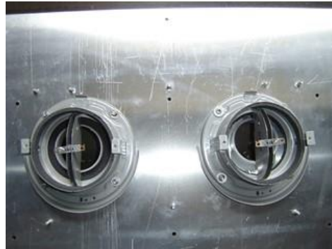
フード取付板取付状態図(給排)
