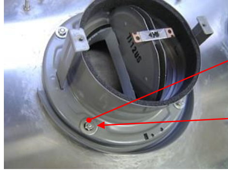
フード取付板取付状態図(給排)
