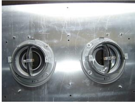
フード取付板取付状態図(給排)
