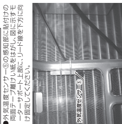
● 外気温度センサー⑨のリード線を、約40mmの位置で曲げ、上下2カ所を⑩⑪で固定してください。尚、下側の⑩は外気温度センサーリード線と一緒に固定してください。
