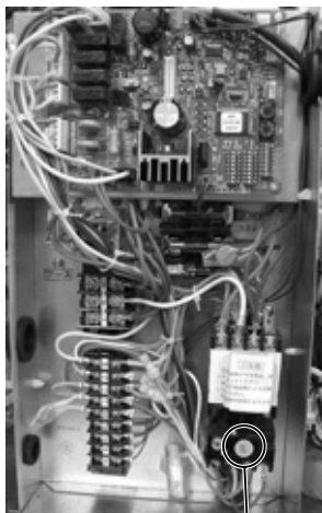
熱動過電流継電器(51C)
