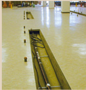
店舗内は地中(ピット)内で配管が導かれショーケースへ接続される
