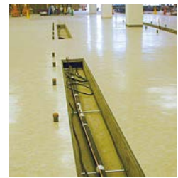
店舗内は地中(ピット)内で配管が導かれショーケースへ接続される
