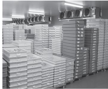
▲第三アトリエの冷凍庫にはバックアップ用も含めてユニットクーラを2系統設置
