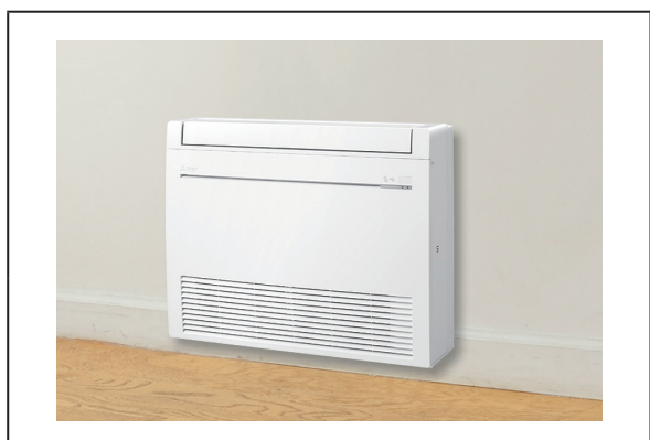
<図4>床置形用壁掛金具使用設置事例
