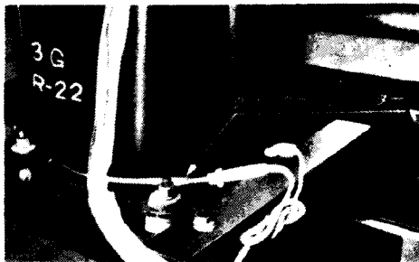
図6-26 クランクケースヒーターの取付
