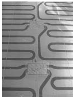
◆配管接続部のテープ貼り
