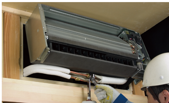
点検口より配管を接続
