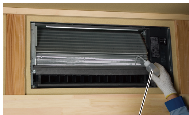
ドレン水の注入
